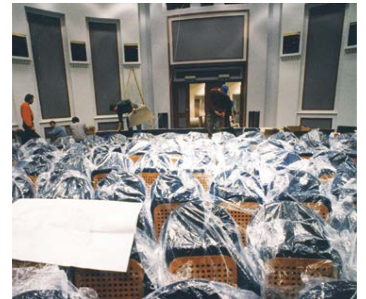
Ολύμπιον εξωτερικό και εργασίες στο εσωτερικό
